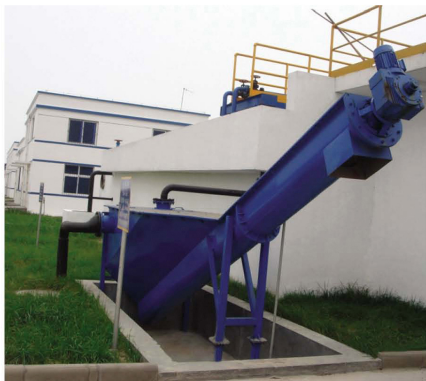
LSSF 型无轴螺旋式砂水分离器 主要技术参数: 处理量: 12-35l/s 螺旋直径: 260-420mm
