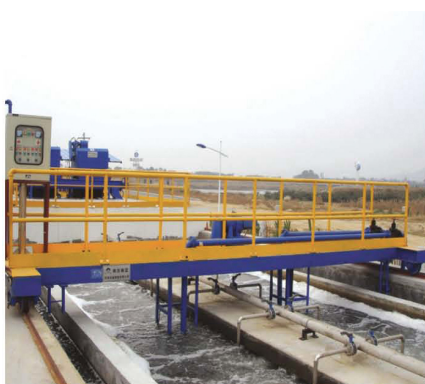
XS 型沉砂池吸砂机 主要技术参数 池宽: 2-12m
