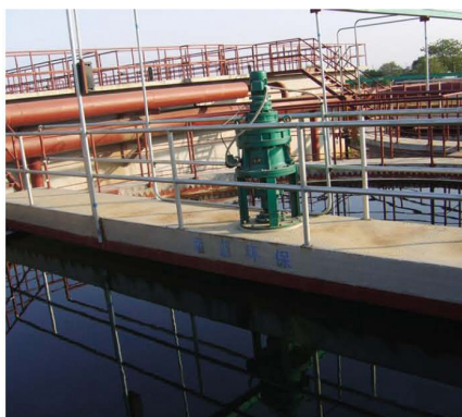
ZXG 型悬挂式中心传动刮泥机(浓缩机) 主要技术参数: 池直径: 4-16m
