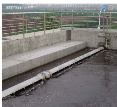
JYZG 型集油集渣管 主要技术参数: 管径: 250-500mm
