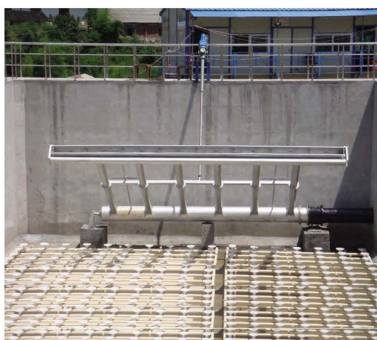
XBS 型旋转式滗水器 主要技术参数: 排水量: 100-2000m³/h 堰长: 1.5-22m
