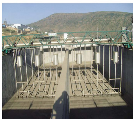
P·XB/HXN 型给水沉淀池泵 /虹吸式吸泥机 主要技术参数: 池宽: 4.3-25.3m
