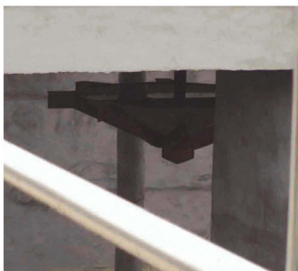
DS 型倒伞型立式表面曝气机 主要技术参数 叶轮直径: 1400-3000\text{mm}
