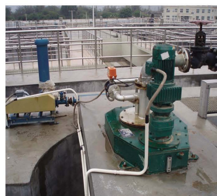
XLCS 型旋流沉砂池除砂机 主要技术参数: 处理量: 180-7800m 3 /h
