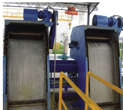
GSLH 型链条回转多耙格栅除污机 主要技术参数 设备宽度: 800-3000mm 栅隙: 15-50mm
