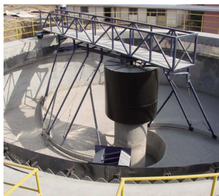
ZBGN 型周边传动桥式刮泥机 主要技术参数: 池直径: 14-55m
